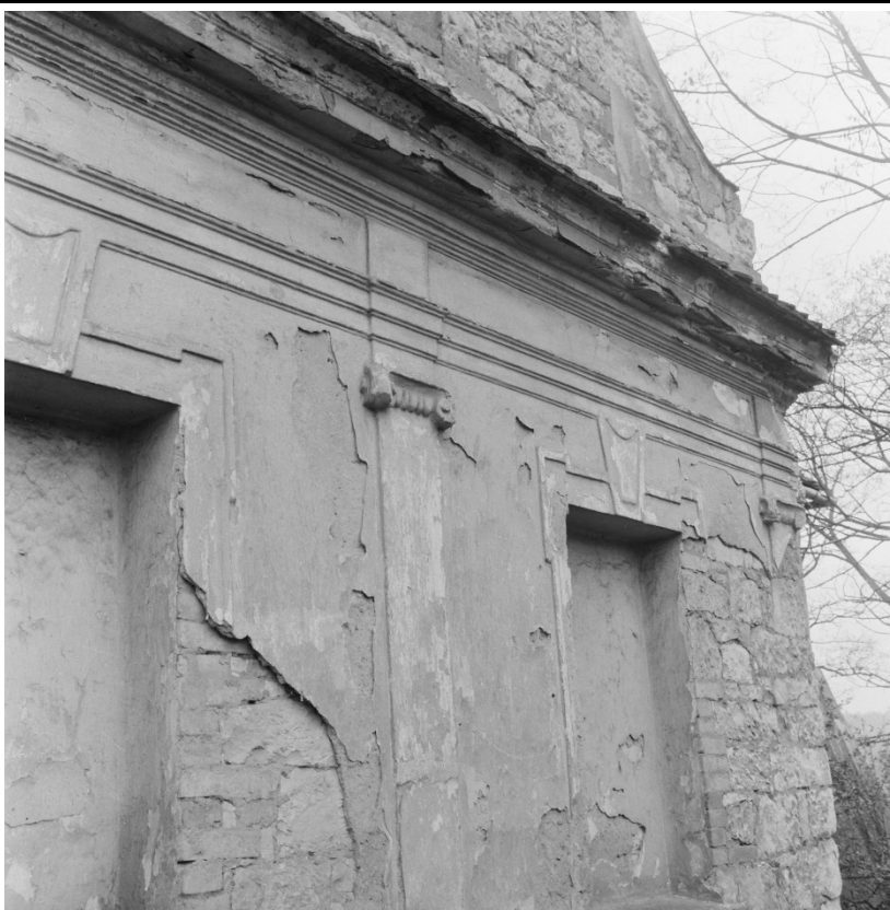
Severní průčelí sakristie v pohledu od severovýchodu. Foto: 1967, sbírka negativů NPÚ ÚOP v Ústí n. L., sign. 28109.
