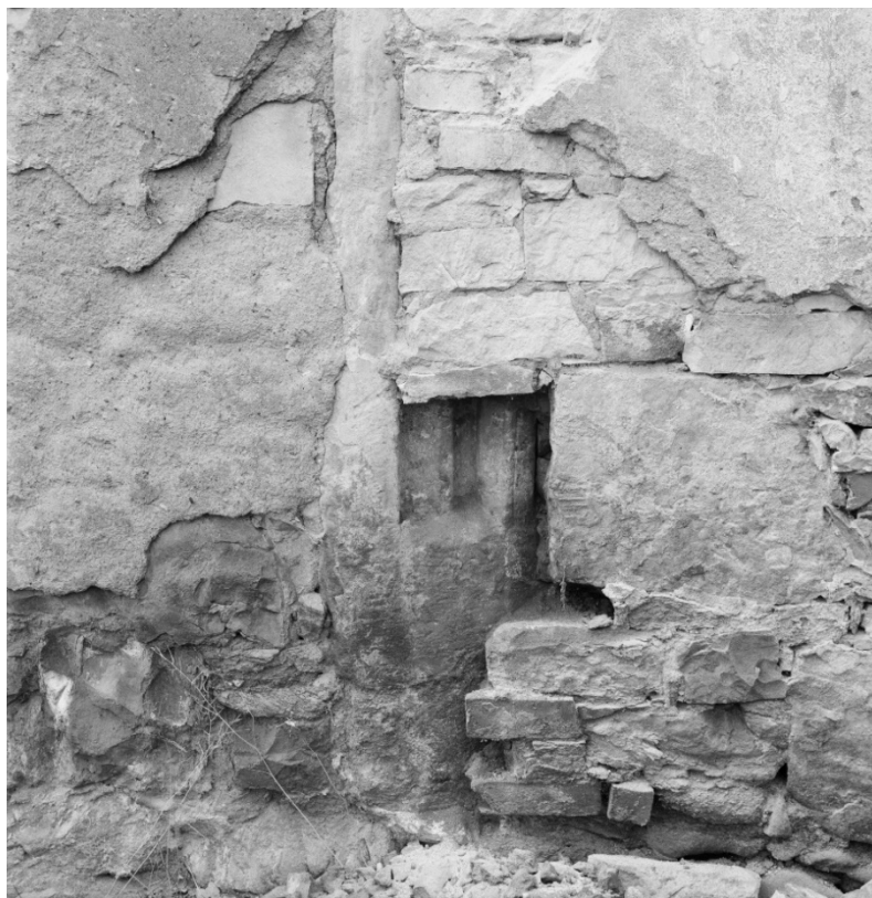
Detail západní stojky středověkého portálu. Foto: 1987, sbírka negativů NPÚ ÚOP v Ústí n. L., sign. 154666.
