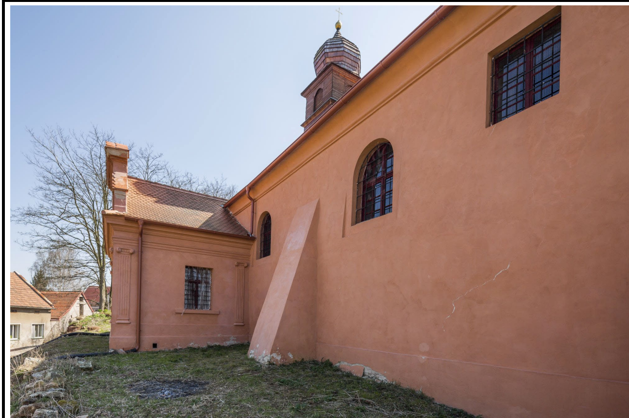
Severní průčelí lodi a západní průčelí sakristie v pohledu od severozápadu. Foto: Marta Pavlíková, 2020.
