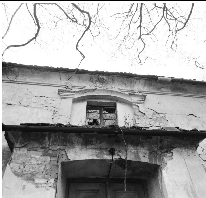
Detail okenního otvoru v ose západního průčelí lodi v pohledu od západu. Foto: 1988, sbírka negativů NPÚ ÚOP v Ústí n. L., sign. 81252.
