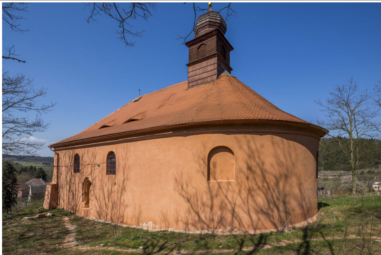
Celkový pohled od jihovýchodu. Foto: Marta Pavlíková, 2020.
