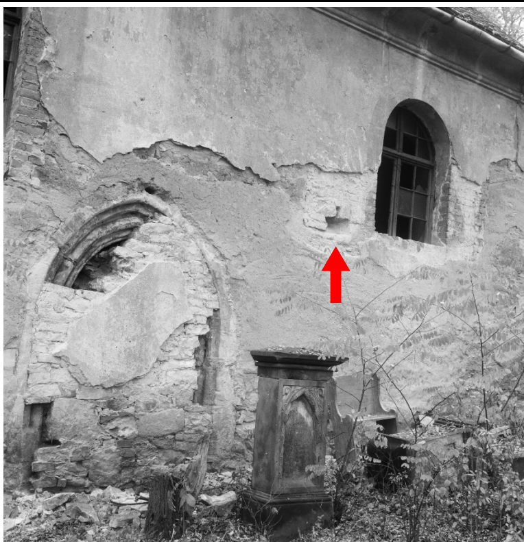
Jižní průčelí lodi v pohledu od jihu s odhaleným středověkým portálem lodi a výše napravo ležící spodní část středověkého okenního ostění (vyznačeno šipkou). Foto: 1987, sbírka negativů NPÚ ÚOP v Ústí n. L., sign. 154663.
