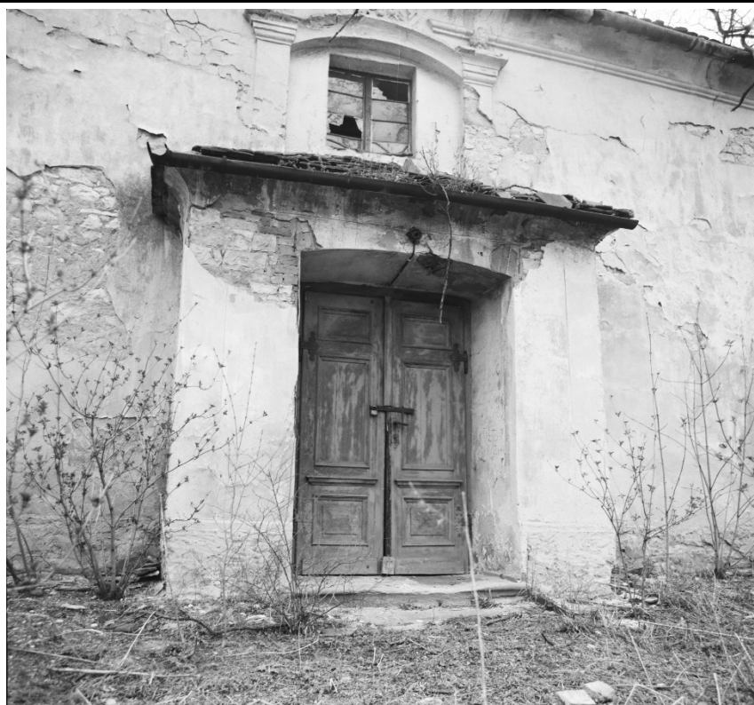
Západní průčelí lodi se vstupem v pohledu od západu. Foto: 1988, sbírka negativů NPÚ ÚOP v Ústí n. L., sign. 81251.
