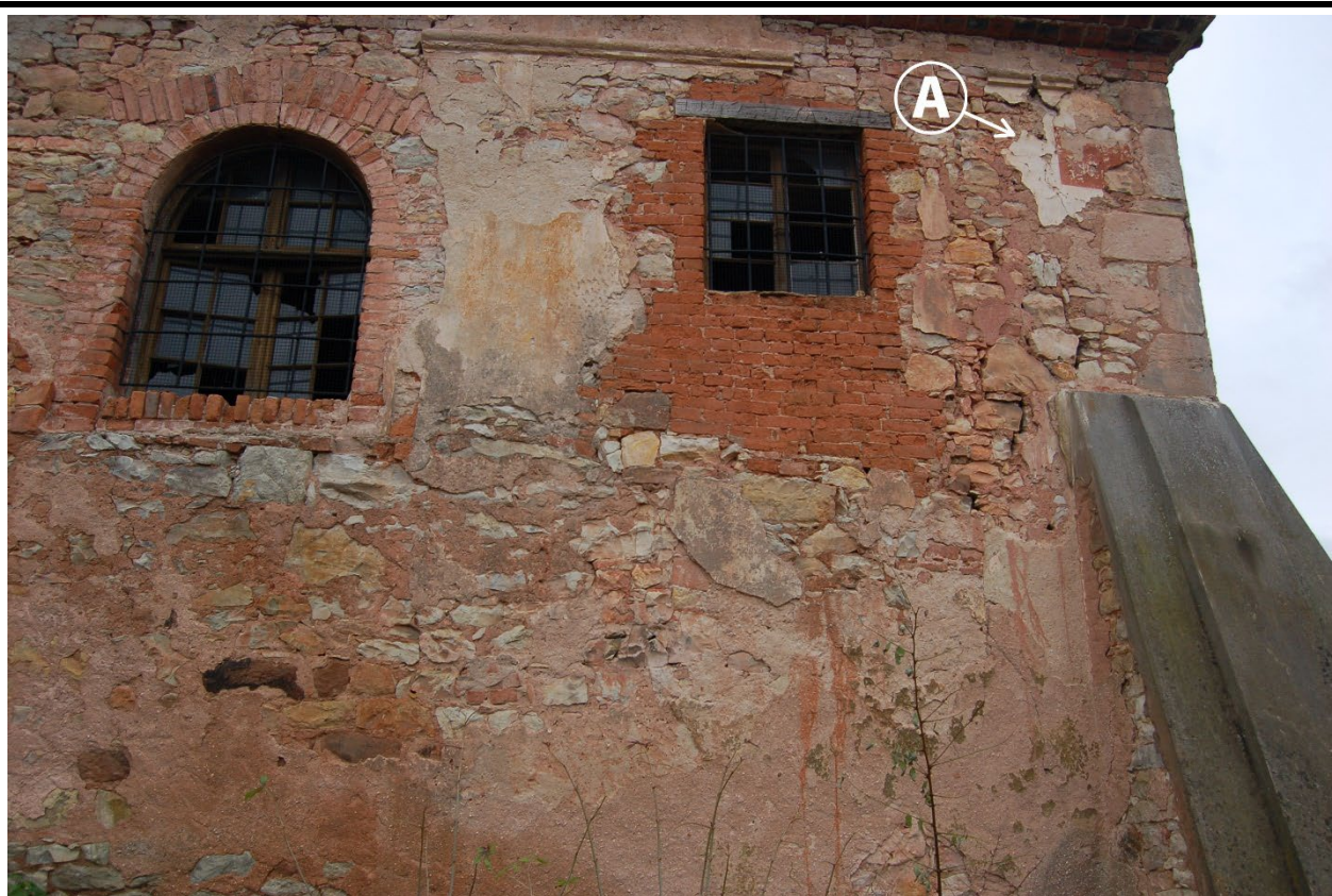
Západní část severního průčelí lodi v pohledu od severu. A – fragment s barokní omítkovou úpravou s bíle natíranou základní plochou a červeně malovaným kvádrováním. Foto: Veronika Bartošová, 2007.
