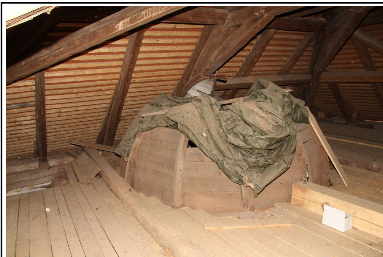
Dřevěná kupole nad západní kruchtou v pohledu od jihovýchodu z prostoru krovu. Foto: Jaroslav Skopec, 2019.
