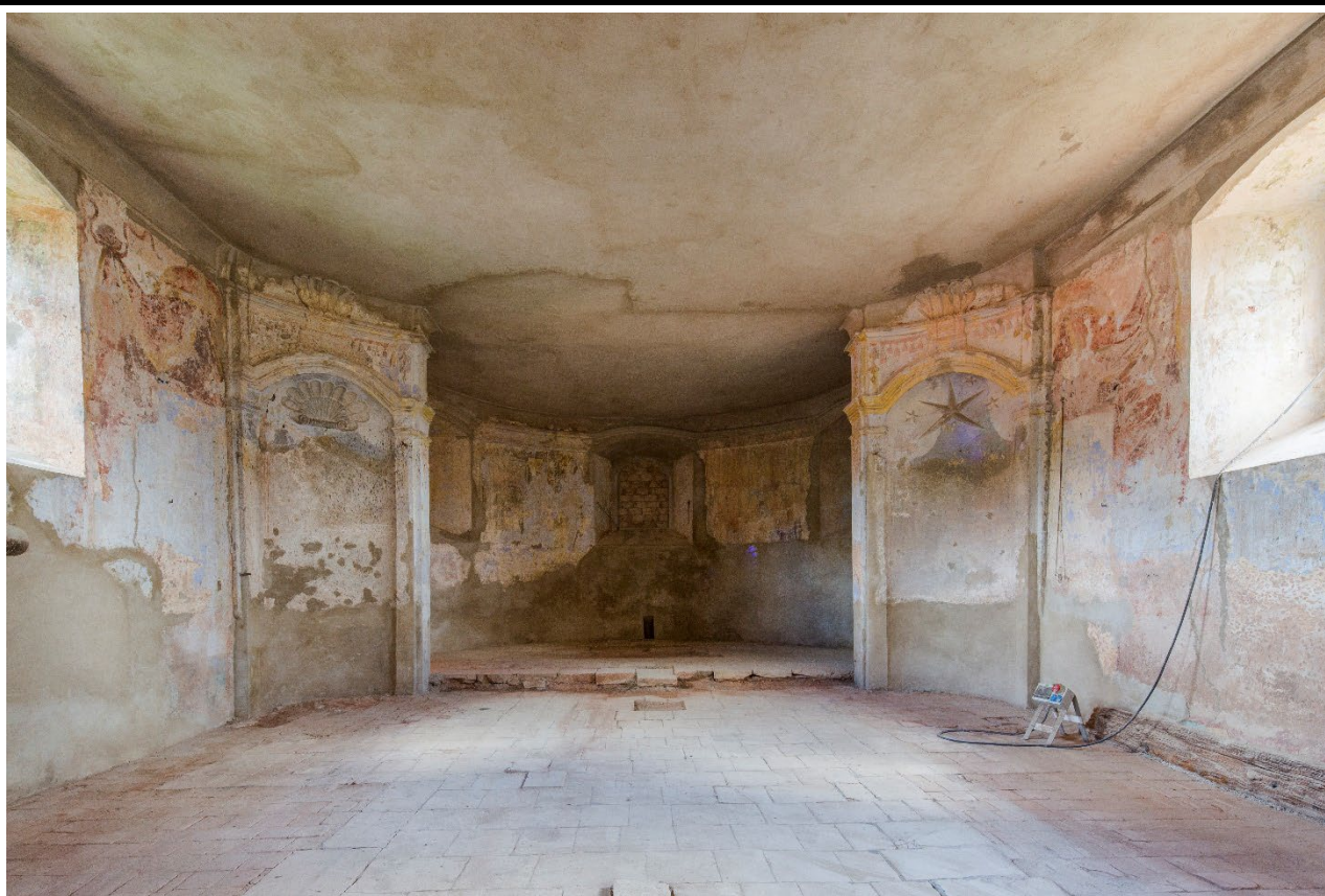
Interiér lodi v pohledu od západu. Foto: Marta Pavlíková, 2020.
