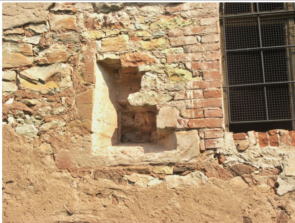
Detail dochované části ostění východního gotického okenního otvoru. Foto: Lucie Radová, 2007.
