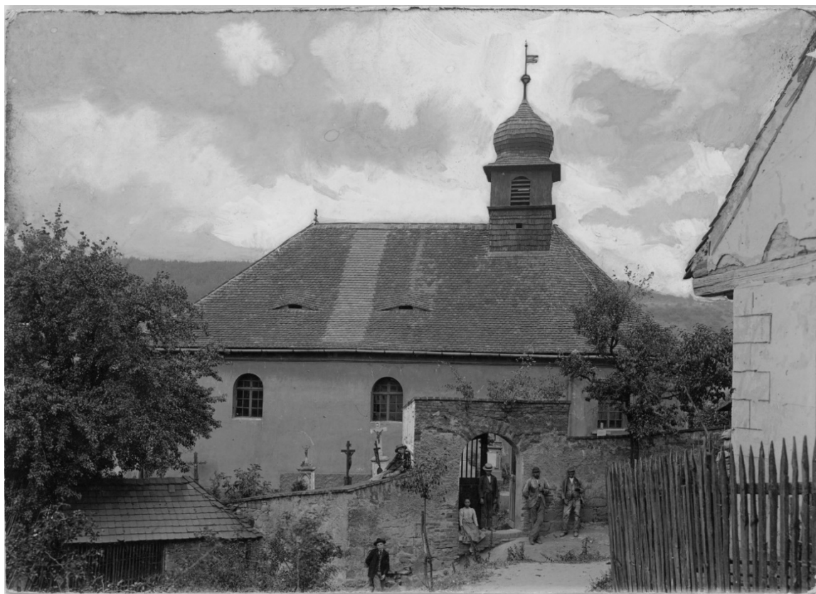
Celkový pohled od jihu na reprodukcii fotografie patrně z roku 1886. Foto: 1987, sbírka negativů NPÚ GŘ, sign. F035826.
