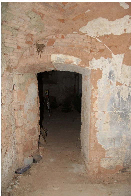
Jižní vstup z presbytáře do sakristie v pohledu od severu ze sakristie. Foto: Jaroslav Skopec, 2019.
