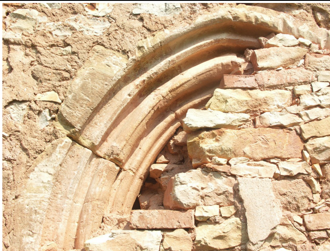
Detail profilace záklenku jižního gotického portálu lodi. Foto: Lucie Radová, 2007.
