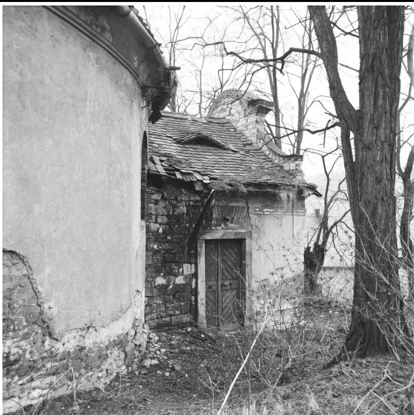
Východní průčelí sakristie v pohledu od jihovýchodu. Foto: 1988, sbírka negativů NPÚ ÚOP v Ústí n. L., sign. 81255.
