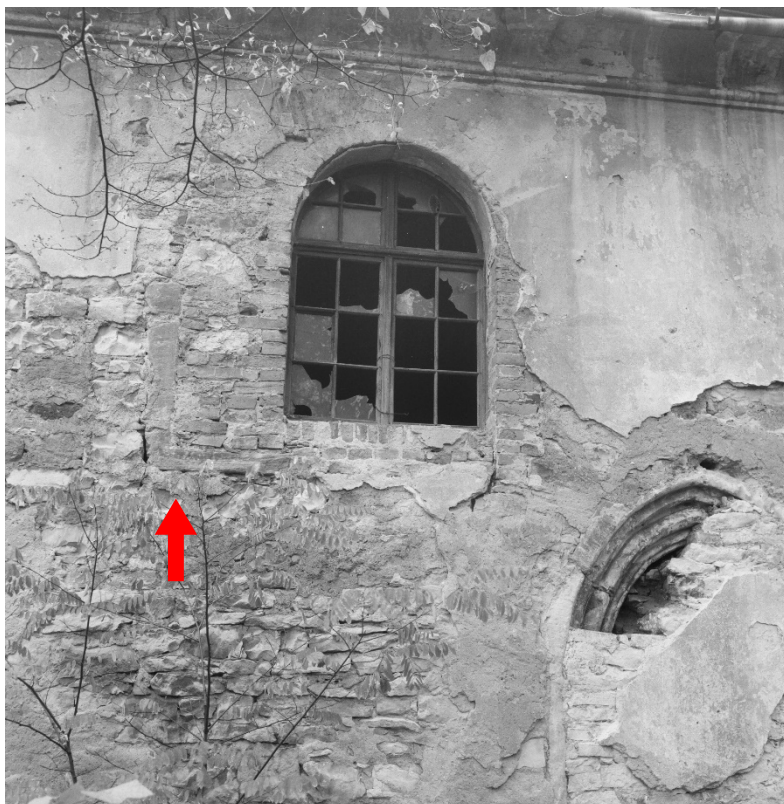
Jižní průčelí lodi v pohledu od jihu s odhaleným středověkým portálem lodi a výše napravo ležící spodní část středověkého okenního ostění (vyznačeno šipkou). Foto: 1987, sbírka negativů NPÚ ÚOP v Ústí n. L., sign. 154664.
