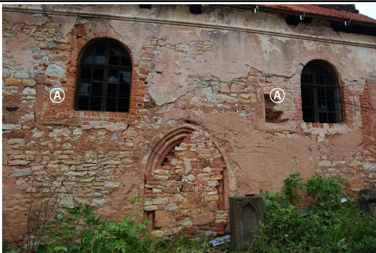
Jižní průčelí lodi v pohledu od jihozápadu. A – Částečně dochovaná ostění zadržných středověkých okenních otvorů lodi. Foto: Veronika Bartošová, 2007.
