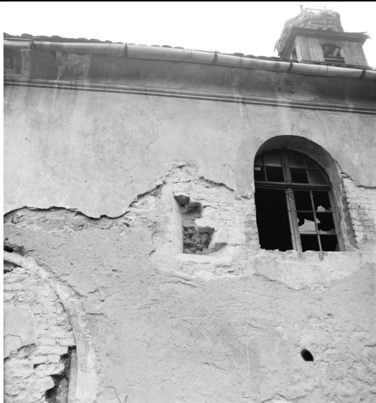
Jižní průčelí lodi v pohledu od jihu s odhaleným středověkým portálem lodi a výše napravo ležící spodní částí středověkého okenního ostění. Foto: 1988, sbírka negativů NPÚ ÚOP v Ústí n. L., sign. 81250.
