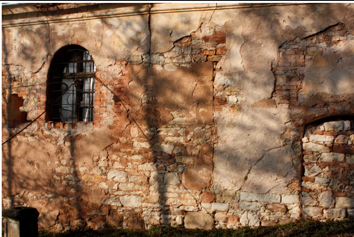
Rozhraní mezi lodí a presbytářem v pohledu od jihu. Na snímku je zřetelné armování jihovýchodního nároží středověké lodi. Napravo se nachází zazděný jižní vstupní otvor presbytáře, který snad může souviset se starší barokní sakristií, nebo prostorem budovaným pro křtitelnicu v 80. letech 18. století. Foto: Lucie Radová, 2015.
