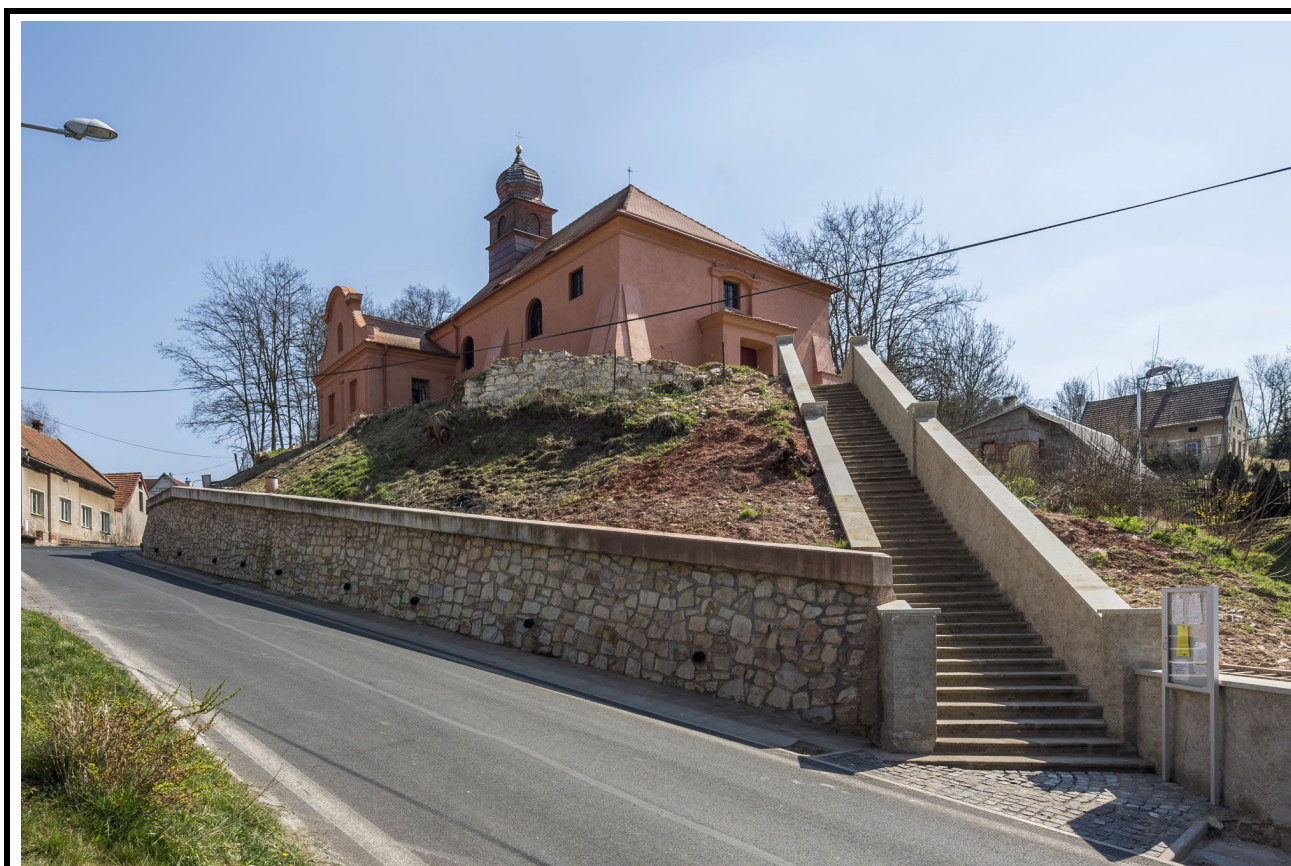
Celkový pohled od severozápadu. Foto: Marta Pavlíková, 2020.
