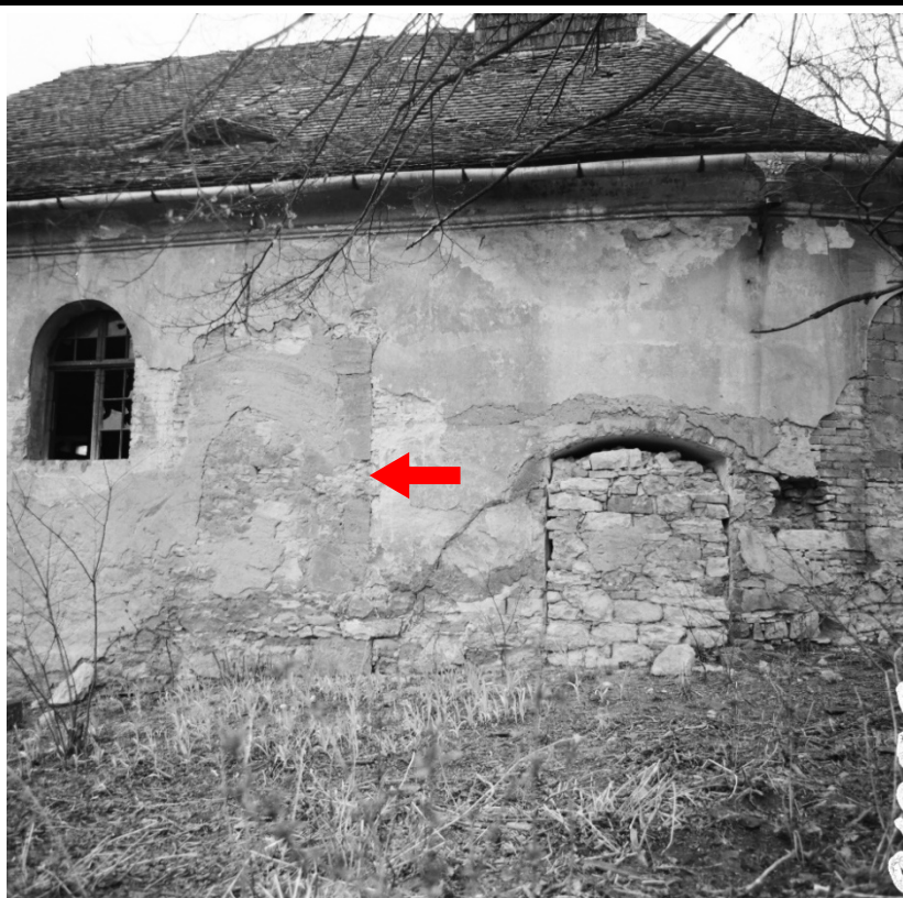
Východní polovina jižního průčelí kostela v pohledu od jihu s patrným jihovýchodním nárožím středověké lodi (označeno šipkou). Foto: 1988, sbírka negativů NPÚ ÚOP v Ústí n. L., sign. 81256.
