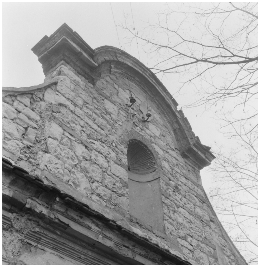
Štít sakristie v pohledu od severovýchodu. Foto: 1967, sbírka negativů NPÚ ÚOP v Ústí n. L., sign. 28108.
