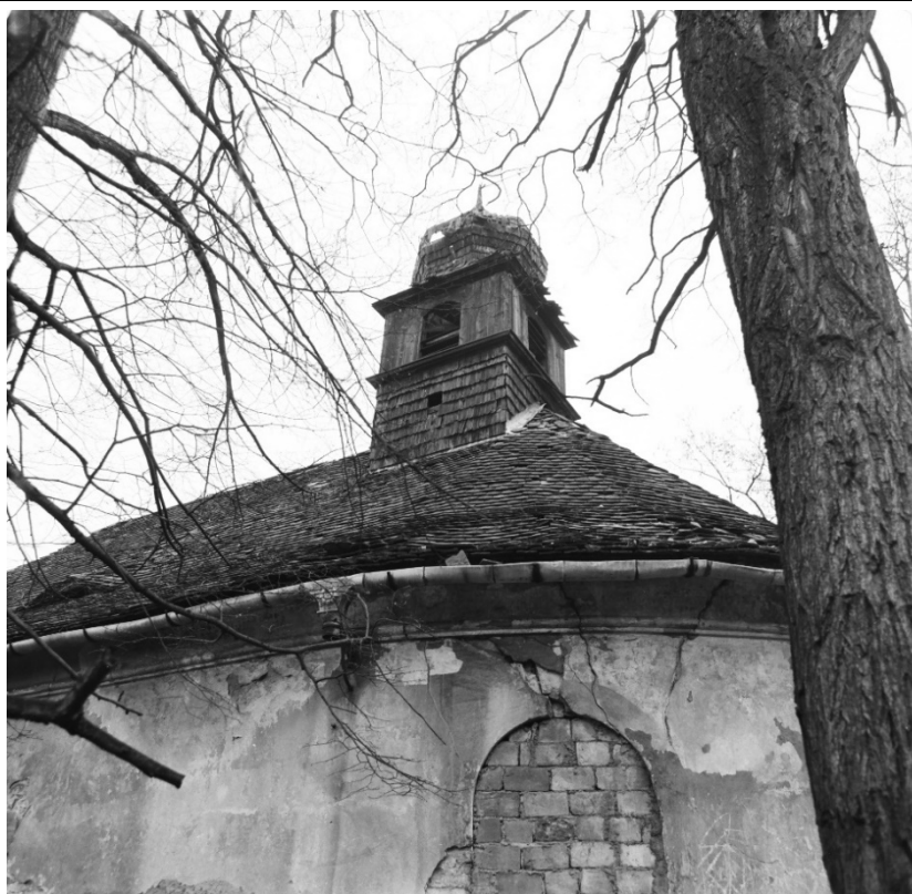
Střecha a sanktusník v pohledu od jihovýchodu. Foto: 1988, sbírka negativů NPÚ ÚOP v Ústí n. L., sign. 81258.
